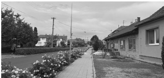
Výměna svítidel veřejného osvětlení probíhá ve Velkých Pavlovicích průběžně. Dle potřeby je měněno i kabelové vedení. Podařila se realizovat výměna v ulicích Bří Mrštíků, Růžová, Herbenova, v části ulice V Sadech a v části Náměstí 9. května.
