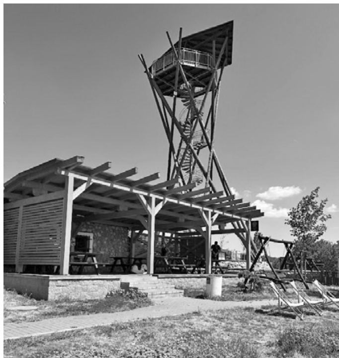
Dosluhující porostlá pergola z dřevěných holovin u rozhledny byla nahrazena zastřešenou pergolou.
