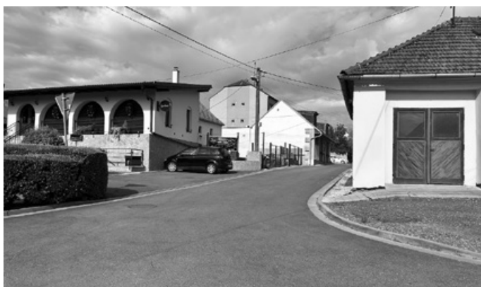
Celková rekonstrukce komunikace v ulici Stará.
