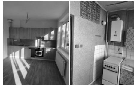
Ukázka rekonstrukce kuchyně v městském bytě v bytovém domě na ulici Nová 2.
