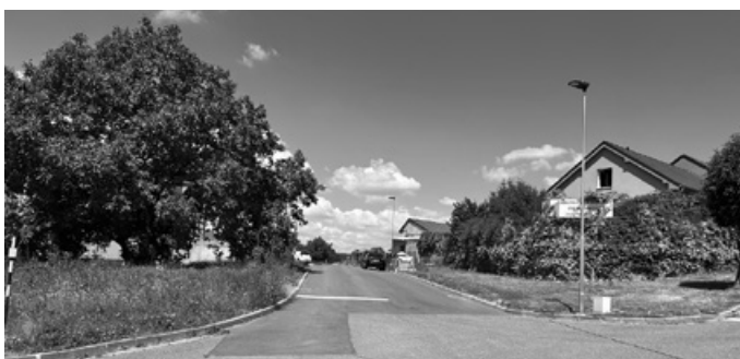
Výstavba části ulice Bří Mrštíků.
