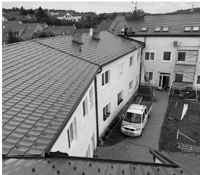
Kompletní oprava střechy na bytovém domě v ulici B. Němcové.
