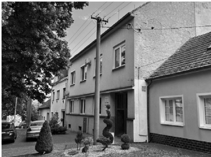
Městu Velké Pavlovice se podařilo koupit budovu zdravotního střediska s přílehlými pozemky. V budově probíhají postupně rekonstrukce jednotlivých prostor dle potřeb.
