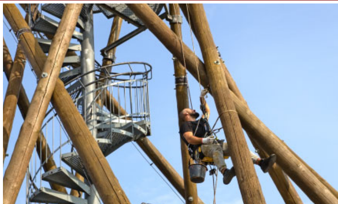
Rozhledna Slunečná se během září dočkala nového ochranného nátěru. Zároveň změnila barvu, z červené na hnědou.
