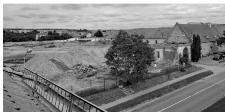
Prostory statku jsou obrovské. Těšíme se, až zazáří moderní novotou.
