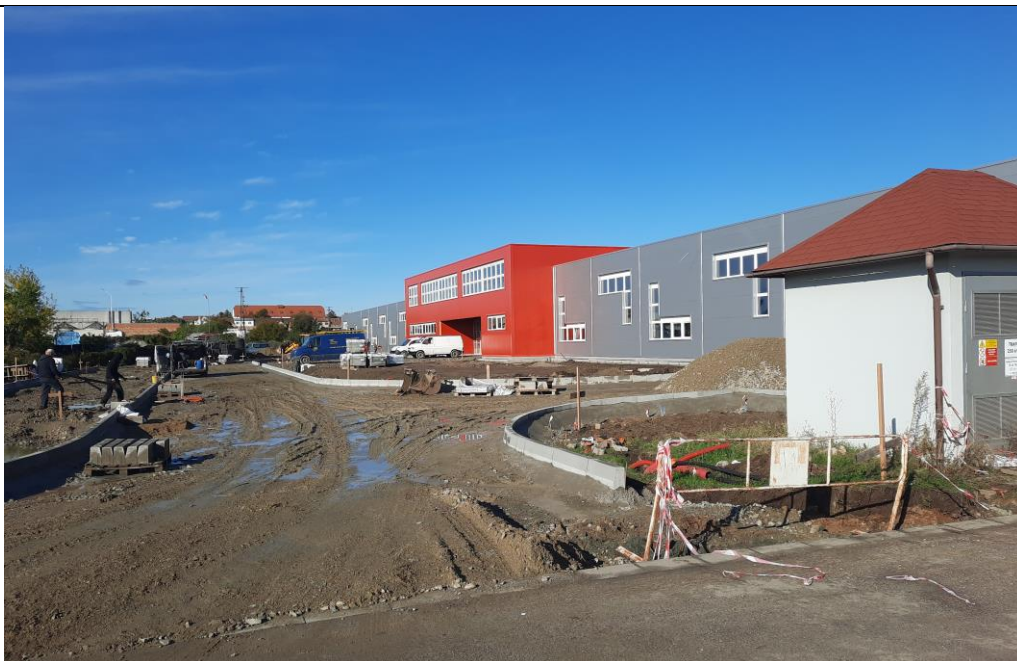
Fotografie řešeného plochy z páteřní komunikace do průmyslové zóny.
