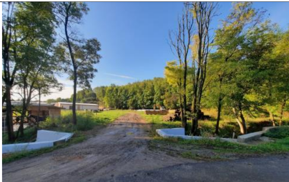
Pohled na řešené území (nová trasa komunikace přes stávající propustek), vzadu realizovaný sklad a výroba vína.
