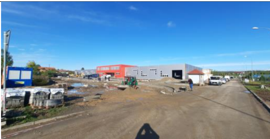
Pohled na řešené území
