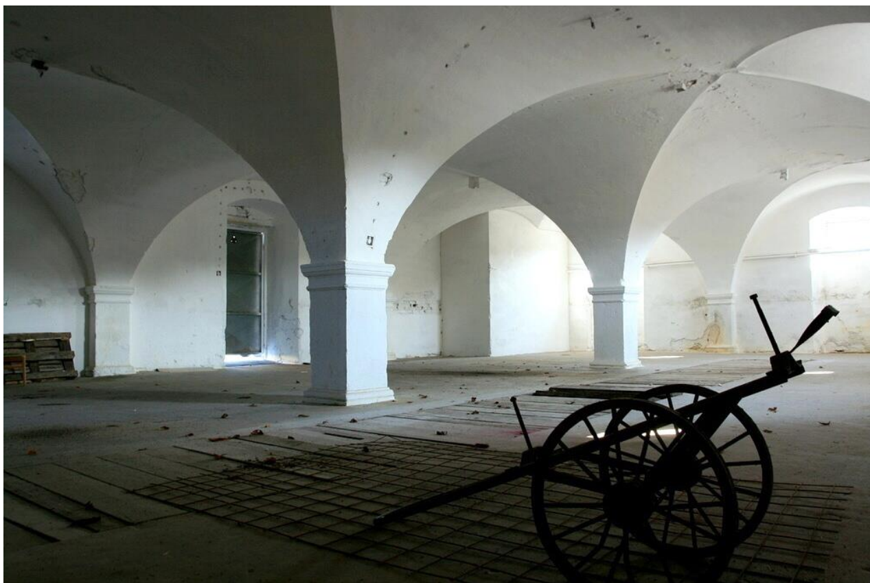
Interiér přízemních prostor velkopavlovické sýpky před zahájením rekonstrukce na hotel.
