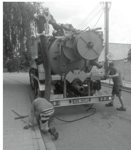
Čištění kanalizačních vpustí u lékárny na Náměstí 9. května.
