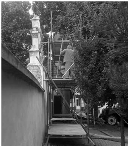
Zahájení opravy hřbitovní brány – stavba lešení.
