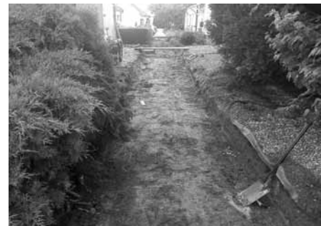
Oprava chodníku na ulici Padělky – vyhloubený kufr chodníku po odstranění staré nevyhovující dlažby.
