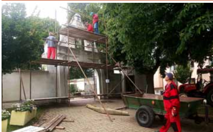
Zahájení generální opravy barokní hřbitovní brány – stavba lešení
