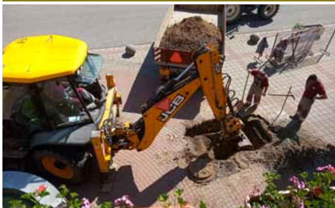
Náměstí 9. května – zahájení opravy vodovodního řadu
