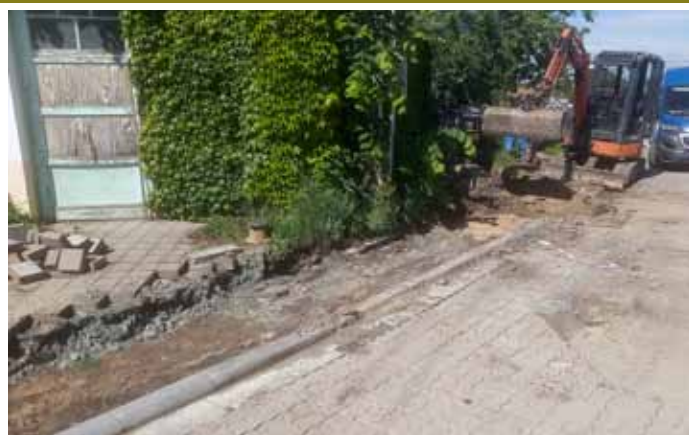
Ulice Padělky – oprava chodníku
