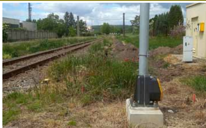
Ulice Hodonínská – výkopové práce předcházející opravě železničního přejezdu, který bude doplněn o závory
