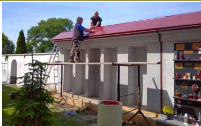
Přístavba kolumbária v prostoru mezi kostelem a hřbitovem
