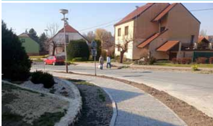
Křižovatka ulic Herbenova, Nová a Náměstí 9. května – dokončení opravy chodníku
