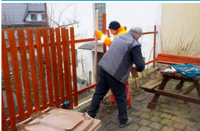
Ulice B. Němcové – oprava lačkového plotu na dvorku bytového domu
