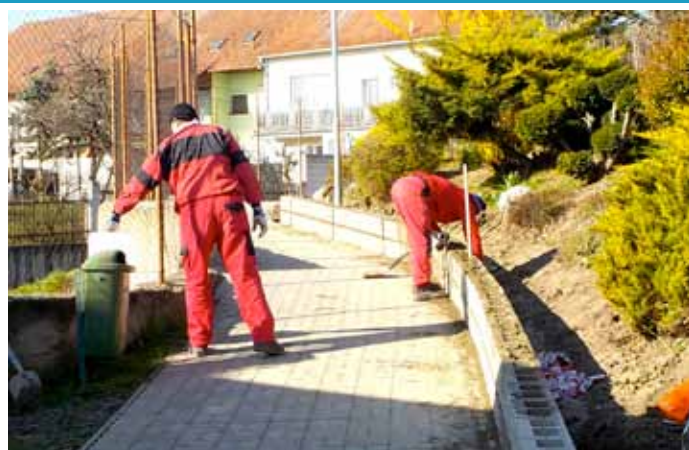
Ulička mezi COOP prodejnou a Pekařstvím Pláteníková – výstavba zpevňovací zídky
