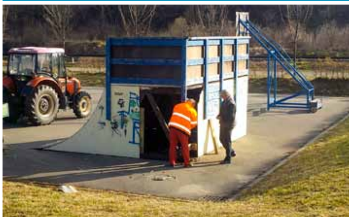
Oprava a údržba sportovních prvků ve skateparku nedaleko vlakové zastávky
