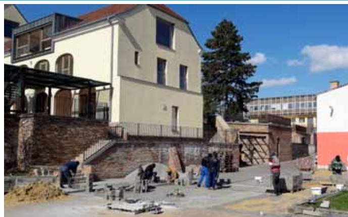
Areál TJ Slavoj – oprava příjezdové vozovky a parkoviště
