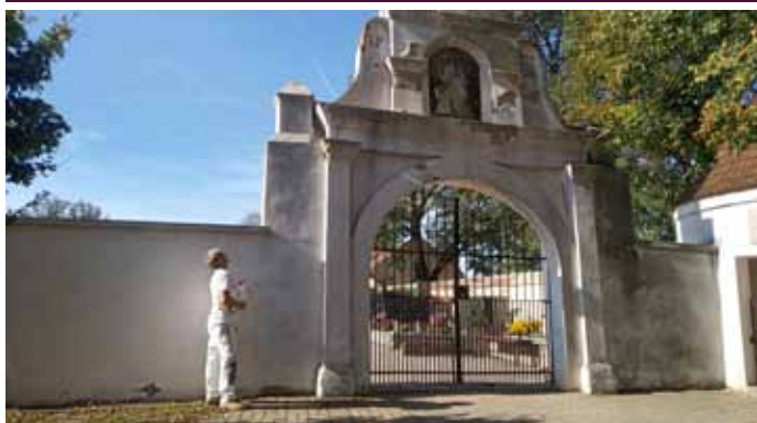
Velkopavlovická hřbitovní brána projde generální opravou pod dohledem památkářů, na snímku pan Vykoukal, umělecký štukatér
