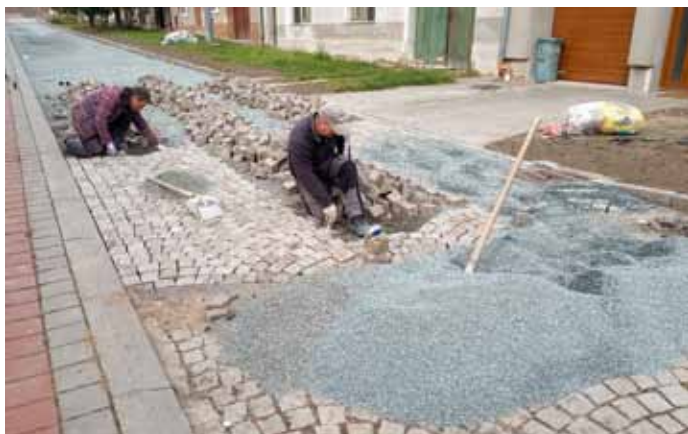
Ulice Střední – pokládka žulových dlažebních kostek
