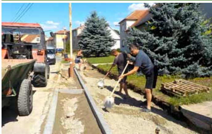
Ulice Herbenova – oprava chodníku
