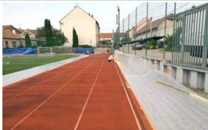
Oprava běžecké dráhy na stadionu za školou
