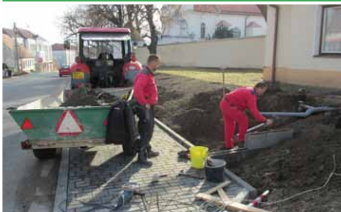
Budování přístupového chodníku k hasičskému domovu a terénní úpravy okolního pozemku
