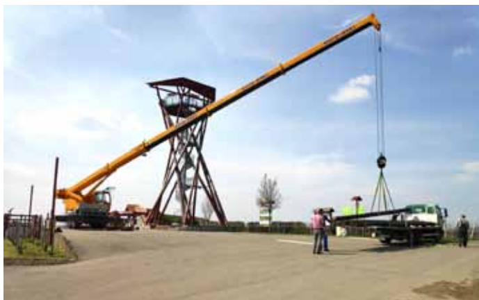
Zahájení opravy rozhledny Slunečná – výměna dřevěných kúlů
