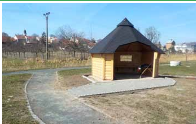
Nová zpevněná přístupová plocha k altánku v relaxačním parku u Trkmanky
