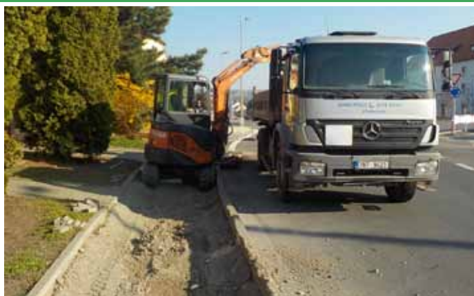
Zahájení oprav na ulici Za Dvorem – výměna vodovodního řadu s následnou rekonstrukcí chodníku
