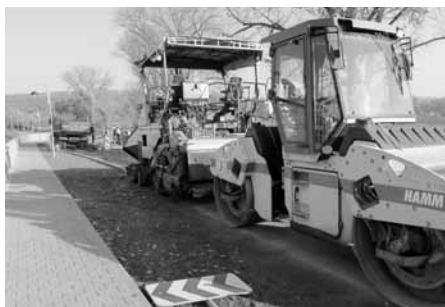
Práce na stavbě vjezdového zpomalovacího ostrůvku u areálu bývalé cihelny.
