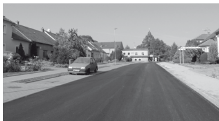
Nový asfaltový povrch na vozovce v ulici Dlouhá.
