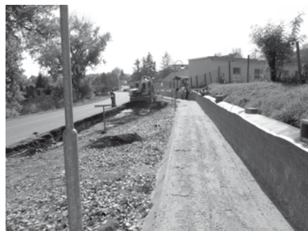
Práce na budování chodníku v ulici Pod Břehy, výjezd z města směr Němčičky.
