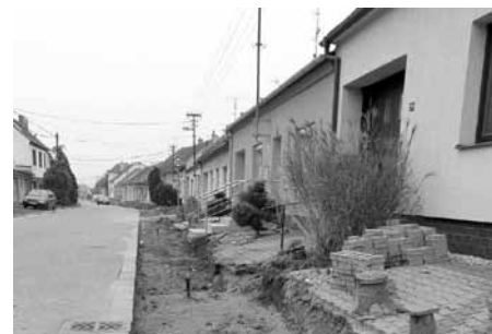
Práce na rekonstrukci chodníku v ulici Zelnice.
