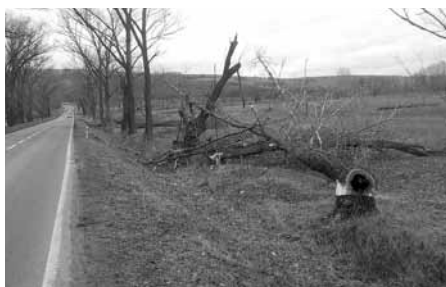
Odborné kácení a bezpečnostní ořez stromů – silnice směrem k obci Němčíčky.
