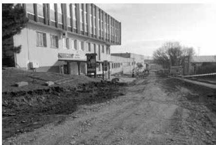
Oprava vozovky na ulici Hodonínská.
