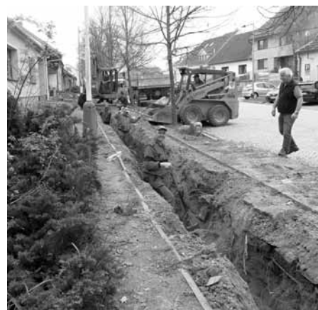
Ulice Hlavní - oprava vodovodního řadu, který je uložen přesně pod chodníkem.
