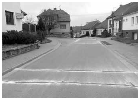
Ulice Úvoz po opravě vozovky technologií zalévání spár elastickou hmotou.
