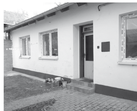
Nová plastová okna na bytovém domě v ulici Trávníky.
