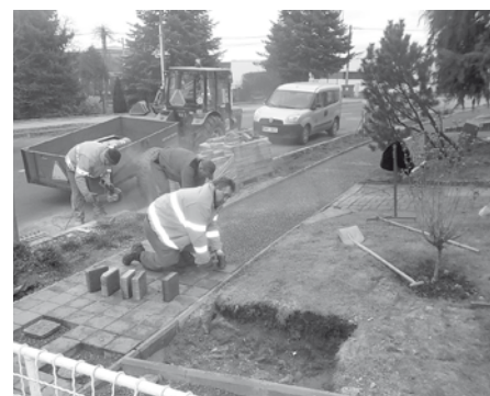
Pokládka zámkové dlažby na chodník v ulici Pod Břehy po opravě havárie vodovodního řádu.
