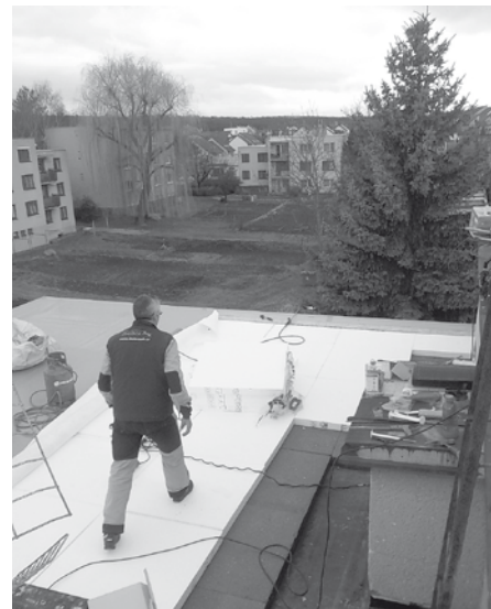
Oprava střechy odbornou firmou na městském bytovém domě v ulici Herbenova.
