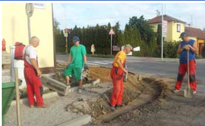
Oprava chodníku na rohu ulic Brněnská a Za Dvorem
