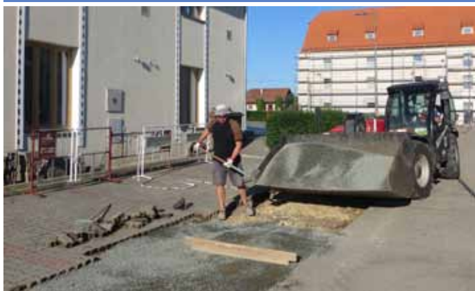
Dláždění části vozovky na ulici Sokolská
