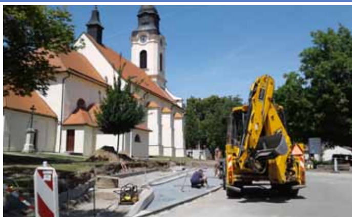
Výstavba nové autobusové zastávky u kostela na ulici Dlouhá
