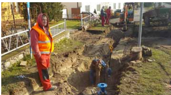
Budování nového úseku chodníku z dlažebních kostek na ulici Nádražní
