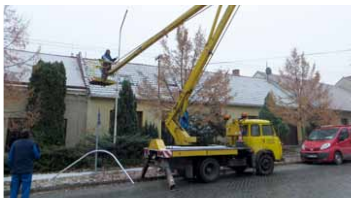
Výměna sloupů a lamp veřejného osvětlení na ulici Hlavní
