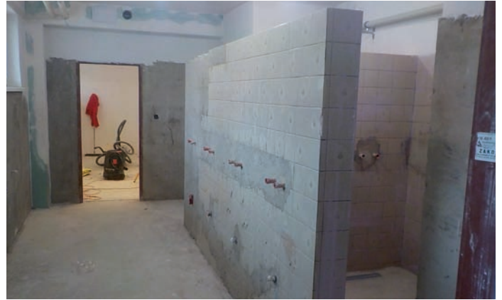
Oprava šaten a sociálního zařízení v tělocvičně při základní škole
