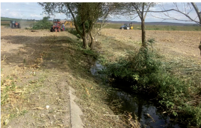
Čištění odtokového žlabu vedoucího z ČOV na ulici Nádražní do Trkmanky
