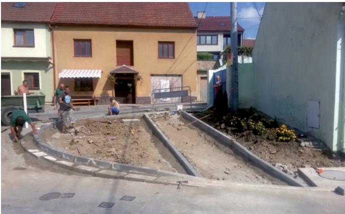
Úprava městského pozemku na spojnici ulic Zelnice a Starohorská
