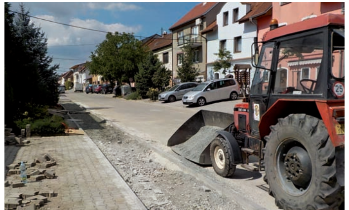
Rekonstrukce chodníku na ulici Zelnice
