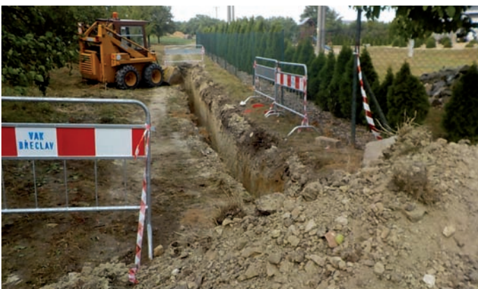
Rekonstrukce přivaděče pitné vody do Velkých Pavlovic, spojnice ulic Zahradní a Vinařská
