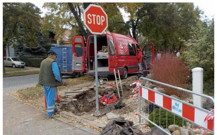
Oprava vodovodního řadu na ulici Hlavní
