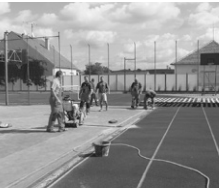
Oprava sportovního stadionu, odstranění původního povrchu.
