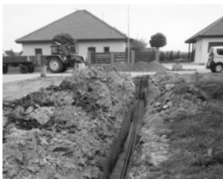
Budování nového vodovodního řadu na Padělkách.
