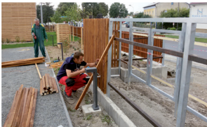
Stavba přístřešku pro popelnice na tříděný odpad v ekocentru
