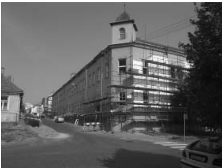
Práce na rekonstrukci a zateplení budovy ZŠ jsou v plném proudu.
