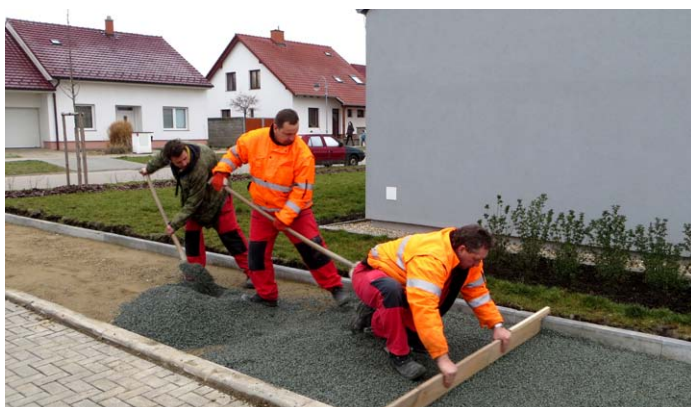
Služby města – budování parkoviště u penzionu pro seniory, ul. Bří Mrštíků
