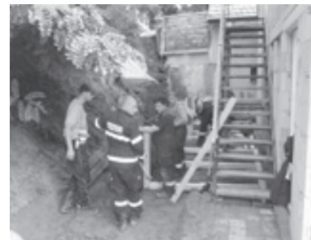
Strachotín – velkopavlovičtí hasiči staví dřevěné zábrany, ochranu před sesouvajícím se podmáčeným svahem.
