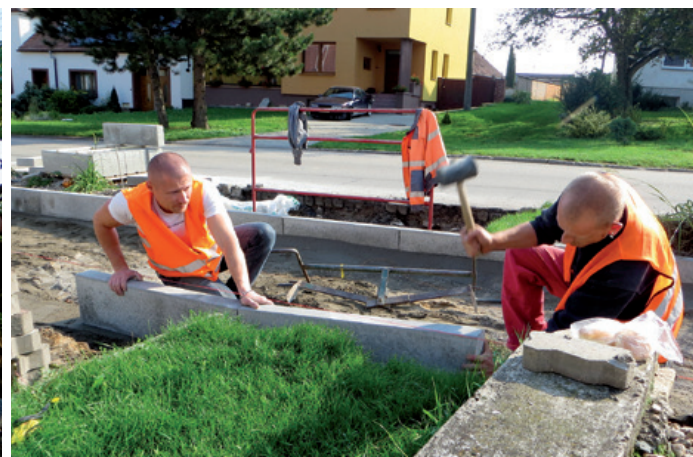
Ulice Dlouhá, oprava chodníku
