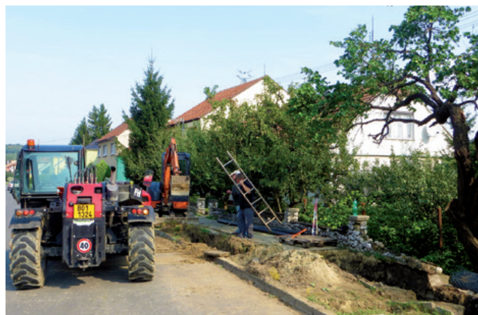
Oprava vodovodního řadu na ul. Pod Břehy
