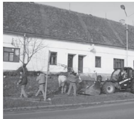
Odstranění náletových dřevin na křižovatce ulic Hlavní a Nádražní.
