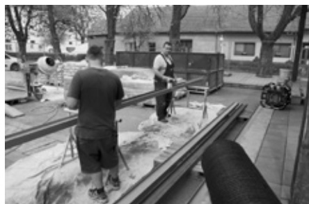
První práce na generální opravě velkopavlovické sokolovny.
