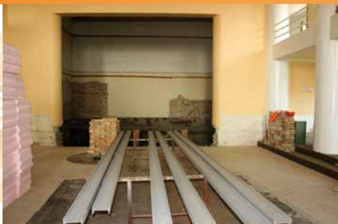
Sokolovna - rekonstrukce interiéru - jeviště
