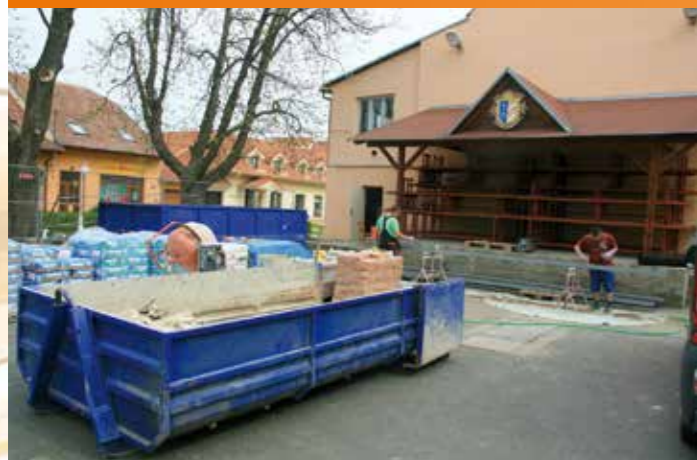
První práce na generální opravě sokolovny
