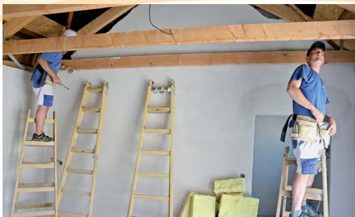
Penzion pro seniory na ul. Brí Mrštíků – zateplení střechy
