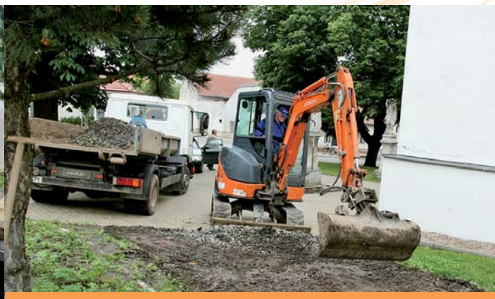
Skrývka zeminy za účelem budování spojovacího chodníku mezi placem před kostelem a kolumbáriem
