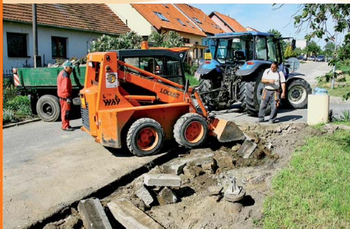
Generální oprava chodníku na ulici Zahradní – demolice
