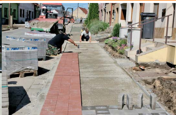
Pokládání dlažby nového chodníku na ul. Ořešová
