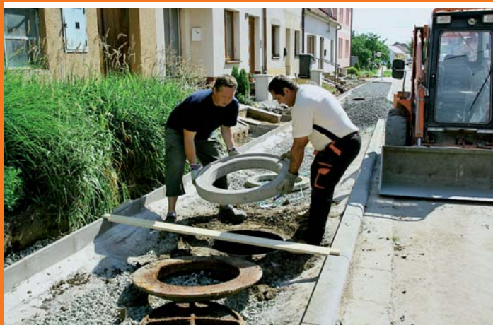
Generální oprava chodníku na ulici Ořešová včetně úprav kanalizačních šachet
