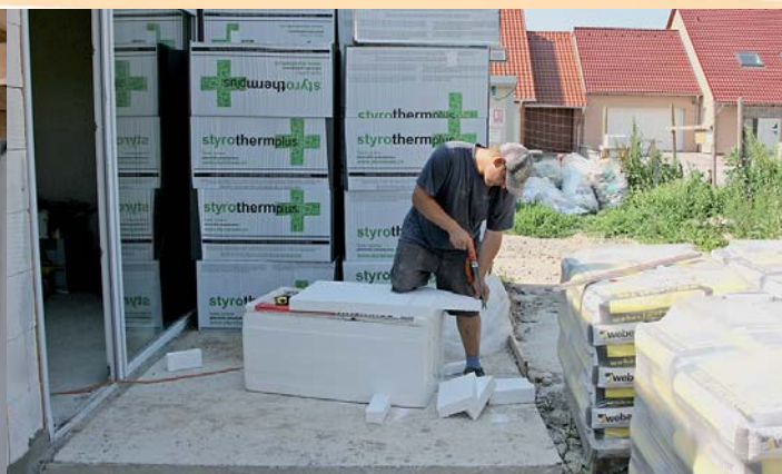
Tepelná izolace penzionu pro seniory
