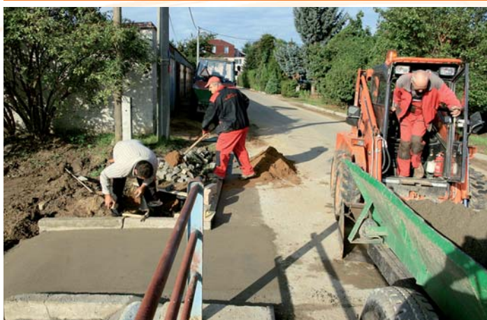
Oprava vodovodního řadu v ul. Nad Zahradami, pokládka obručků.
