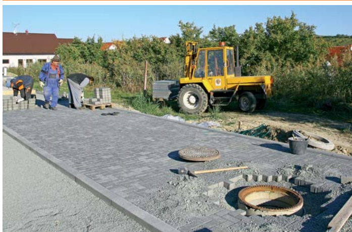
Dláždění vozovky na ul. Ostrovecká.
