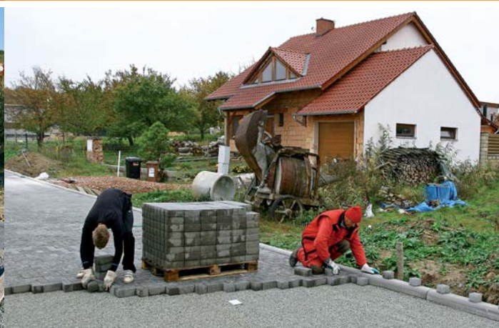
Dláždění vozovky na ul. Horňanského. Obě ulice v lokalitě Padělky.
