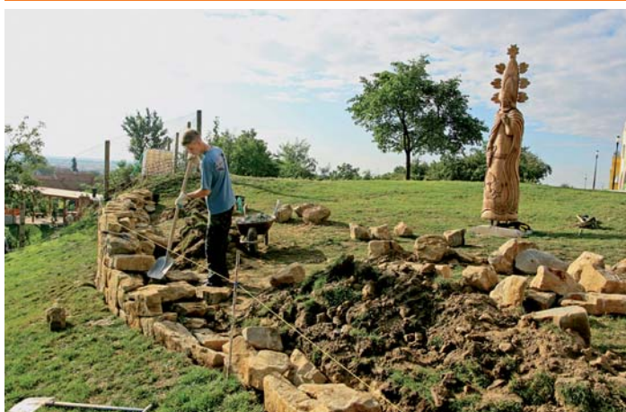
Budování kamenné suché zidky v lokalitě Stará hora.
