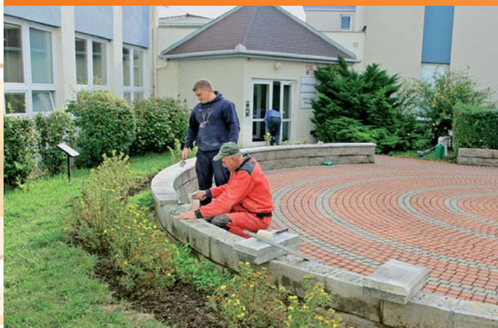
Oprava posezení – laviček před gymnáziem.
