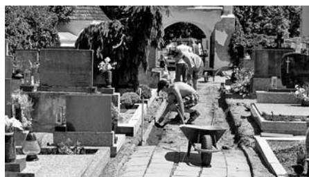
Rekonstrukce nevyhovujících chodníků na hřbitově.
