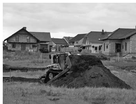
Příprava terénu v lokalitě Padělky – místa pro výstavbu bytů pro seniory.
