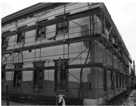
Zateplení historické budovy zámku.
