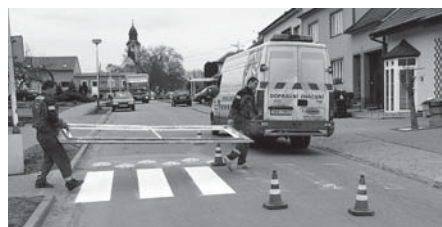
Instalace retardéru na frekventovaném místě ulice Dlouhá včetně zvýraznění přechodu pro chodce.
