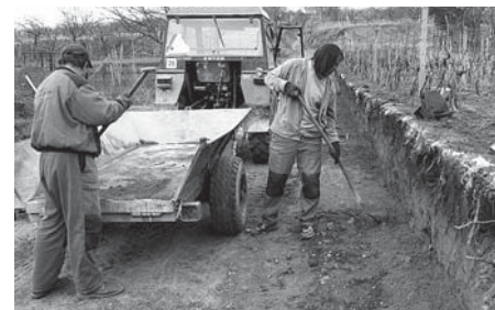
Pracovníci stavební skupiny služeb města připravují základ pro výstavbu opěrné zdi.
