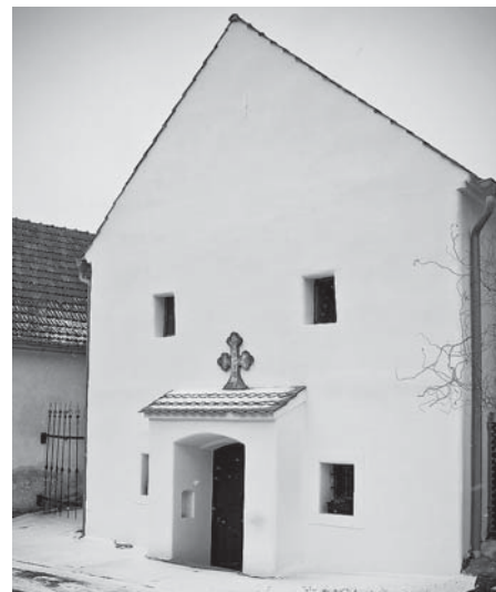
Vinný sklípek rodiny Lacinů po rozsáhlé a náročné rekonstrukci.
