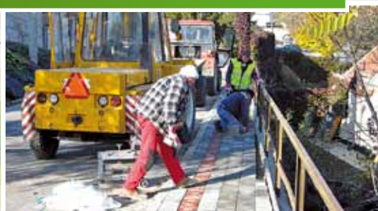
Budování nového chodníku na ulici V Údolí
