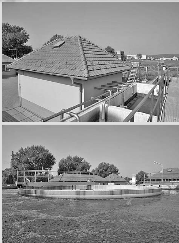
Čistírna odpadních vod ve Velkých Pavlovicích pracuje na plné obrátky.
