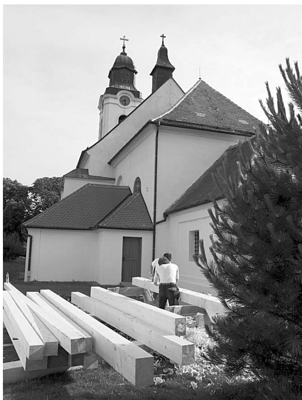
Na opravě střechy kostela pracují tesaři ručně po vzoru starých tesařských mistrů. Foto: Ing. Zdeněk Karber
