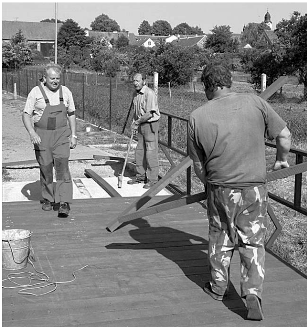
Po mostku přes Trkmanku se projdete po dubovém povrchu.
