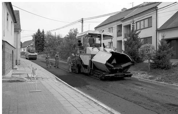
Dokončovací práce na ulici V Údolí spočívaly mj. v položení nového asfaltového koberce vozovky.
