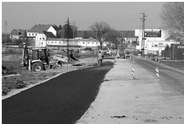
Práce na vybudování podnikatelské zóny pokračují rychlým tempem, nyní jsou zastávky již hotové.
