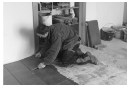
Rekonstrukce interiéru sokolovny, pokládání dlažby.
