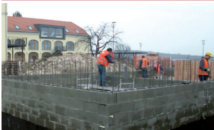
V listopadu byly zahájeny práce na přístavbě ekocentra
