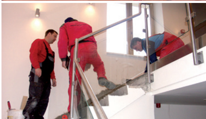
Dokončovací práce na opravě Sokolovny – schodiště a výměna zábradlí v patře budovy
