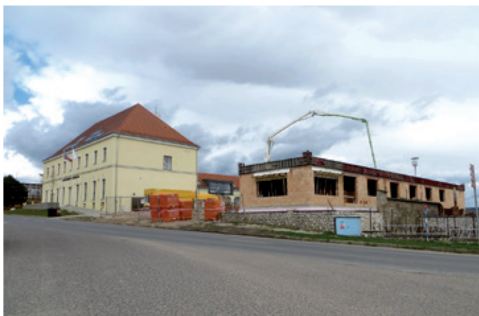
Výstavba nové budovy Ekocentra Trkmanka – betonování pomocí těžké techniky
