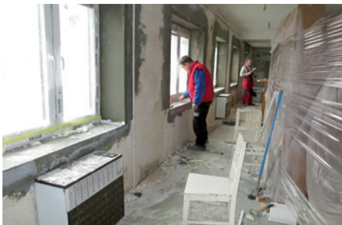
Generální oprava budovy TIC a knihovny
