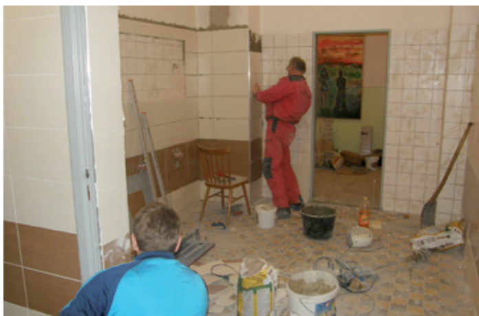
Oprava sociálního zařízení ve školní budově gymnázia
