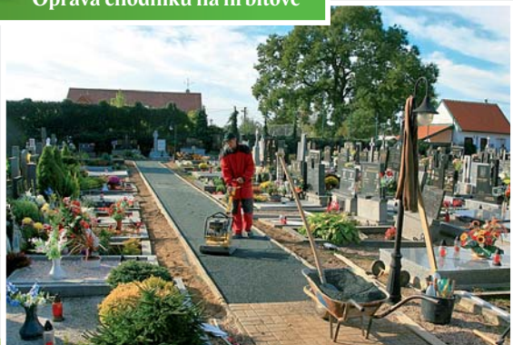
Oprava chodníků na hřbitově
