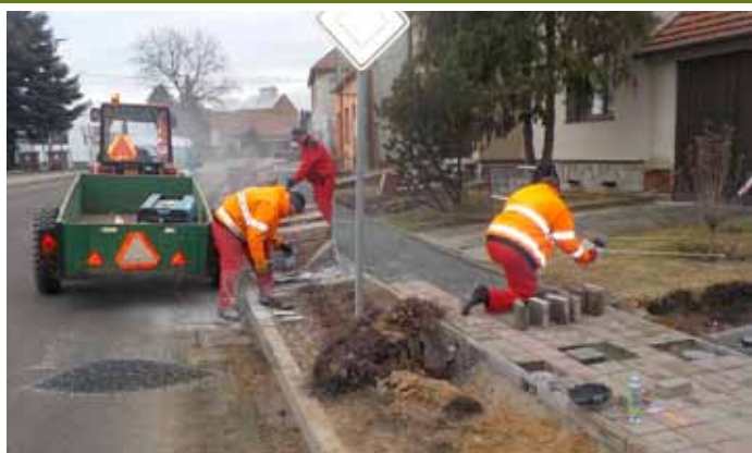
Pokládka chodníkové dlažby po havárii vodovodního řádu na ulici Pod Břehy
