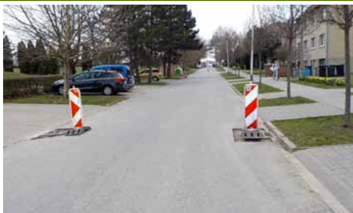
Oprava dešťových vpustí na ulici Bří Mrštíků
