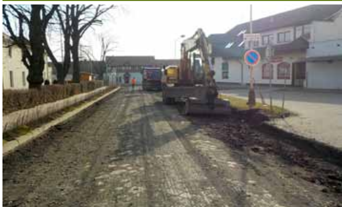
Generální oprava vozovky na křižovatce ulic Hlavní a Brněnská
