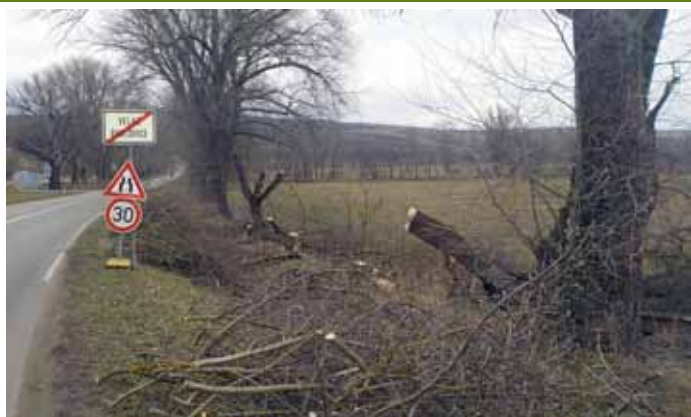
Bezpečností kácení a ozdravný ořez stromů v katastru města – silnice směr Němčičky
