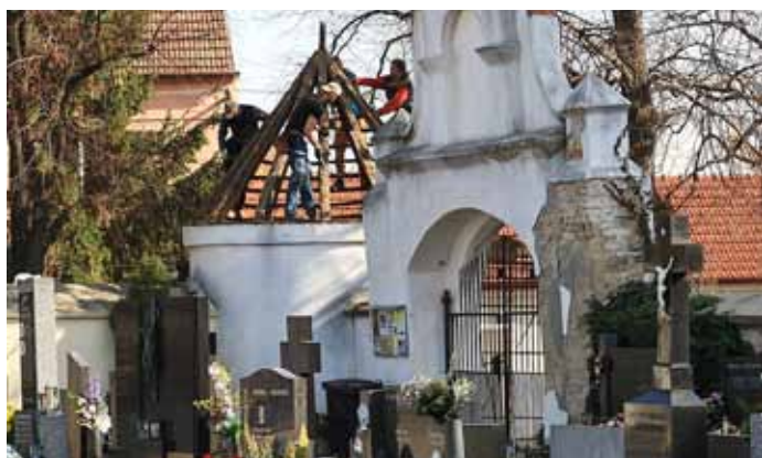
Zahájení rekonstrukce střech nárožních kaplí na hřbitově
