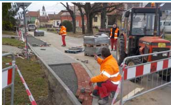
Oprava chodníku na ulici Bezručova – pokládka zámkové dlažby
