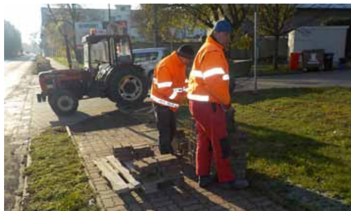
Oprava chodníku na ulici Nádražní – zajištění bezbariérovosti
