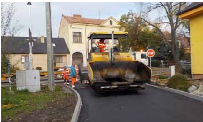
Pokládka živíčního podkladu na vozovku v ulici U Zastávky
