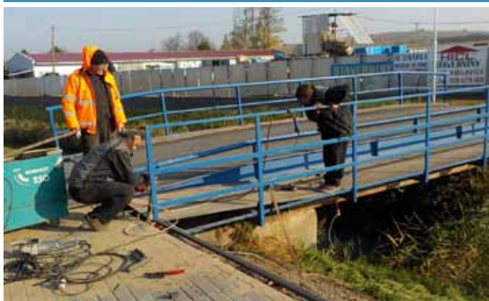
Oprava zábradlí na mostku přes Trkmanku na ulici U Zastávky
