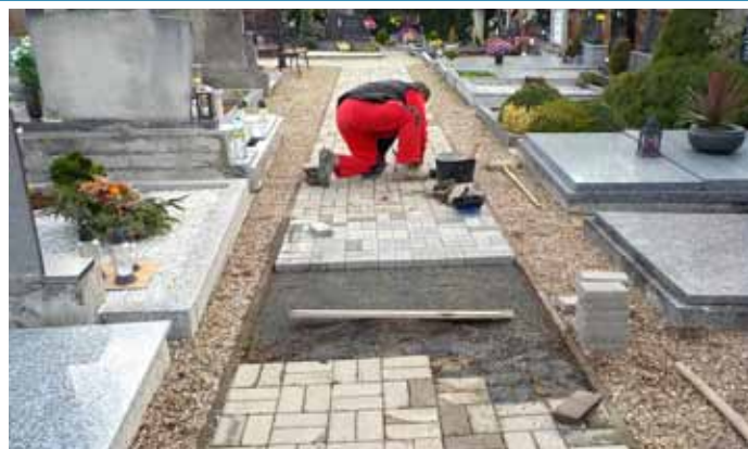
Oprava chodníku na místním hřbitově
