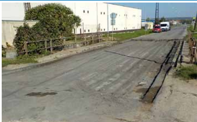
Ulice Hodonínská – oprava mostu přes Trkmanku
