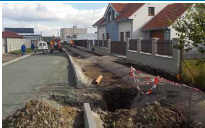
Ulice U Zastávky – Budování nového chodníku
