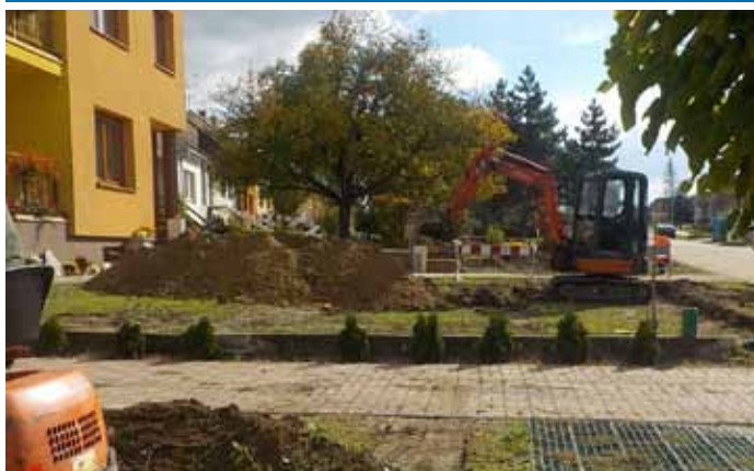
Ulice Dlouhá – rekonstrukce vodovodního řádu
