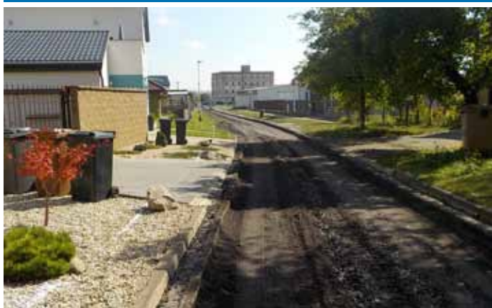
Ulice U Zastávky – Oprava vozovky
