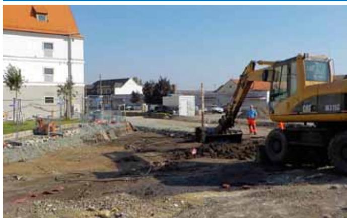
Ulice Brněnská – oprava vozovky za sýpkou
