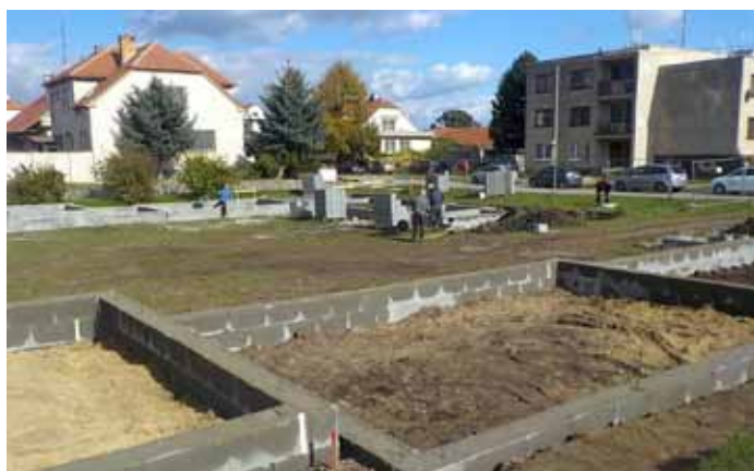
Budování základů nového palovinu bytů pro seniory na ulici Bří Mrštíků, lokalita Padělky
