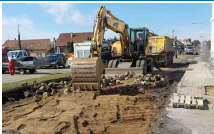
Ulice Brněnská – oprava vozovky v sousedství autobusového nádraží
