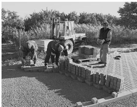
Pokládka dlažby na Ostrovecké ulici.
