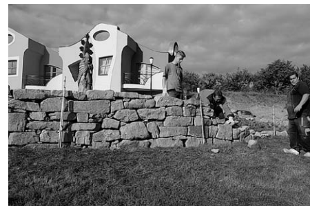
Budování suché kamenné zídky u sochy sv. Urbana pod Starou horou.
