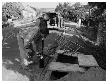
Oprava vodovodu na ulici Pod Břehy.
