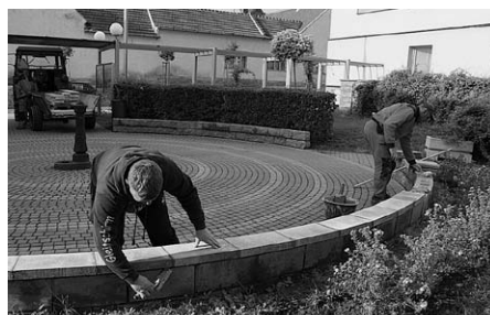
„Kruháč“ před gymnáziem - oprava betonových prvků před osazením nových dřevěných laviček.
