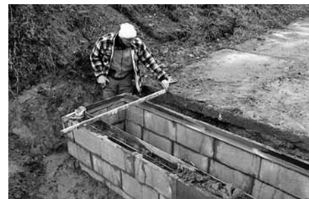
Budování záchytného žlabu u cesty do Staré hory.
