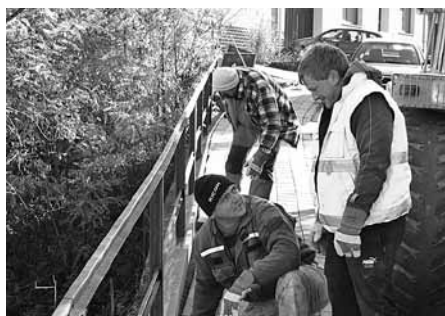
Stavební práce na prodloužení chodníku v ulici V Údolí.
