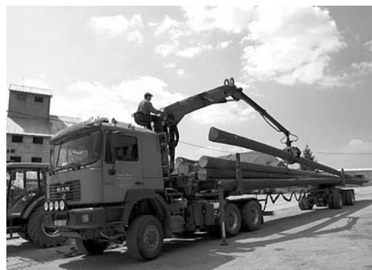
Modřínová kulatina ze Ždírc nad Doubravou potřebná pro výstavbu rozhledny v pořádku dorazila do Velkých Pavlovic, kde byla složena na dvoře ZD. Foto: Ing. Zdeněk Karber
