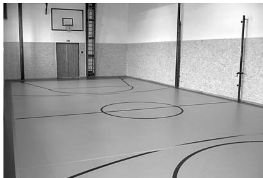
Stará tělocvična v budově základní školy v novém kabátě.
