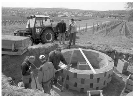
Stavební práce na budování základů kaple sv. Urbana. Foto: Ing. Zdeněk Karber
