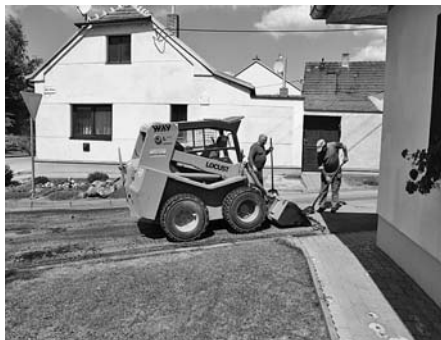
Příprava vozovky na ulici Bezručova na pokládku nového povrchu.
