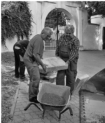
Kolumbárium – pietní místo pro uložení urn, je dokončeno.
