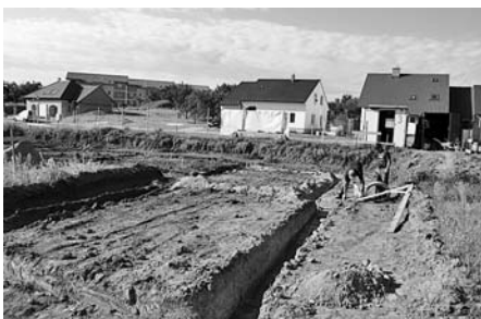
Základy prvních devíti malometrážních bytů pro seniory.
