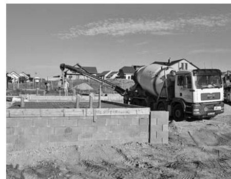
Domky pro seniory se již rýsují, základy byly už začátkem září hotovy.
