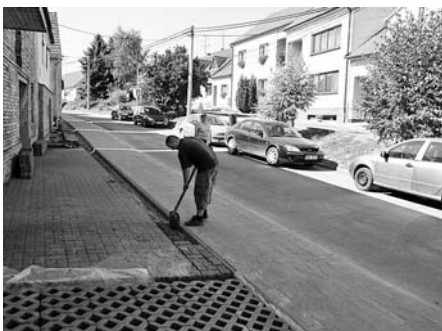
Pokládání dlažby chodníku v ulici V Údolí.
