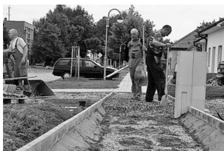
Budování chodníku na ulici Brí Mrštíků v lokalitě Padělky.
