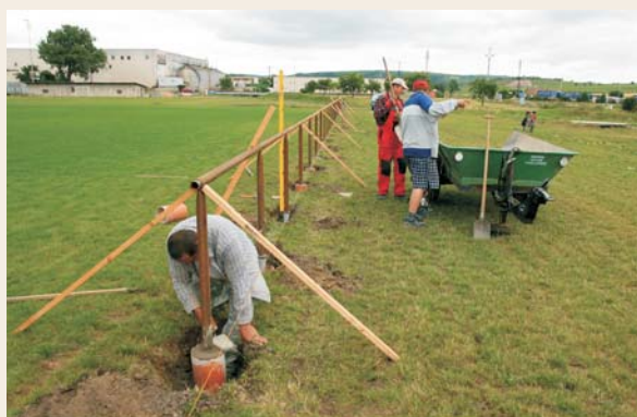
Výstavba odpočívadla pod rozhlednou
