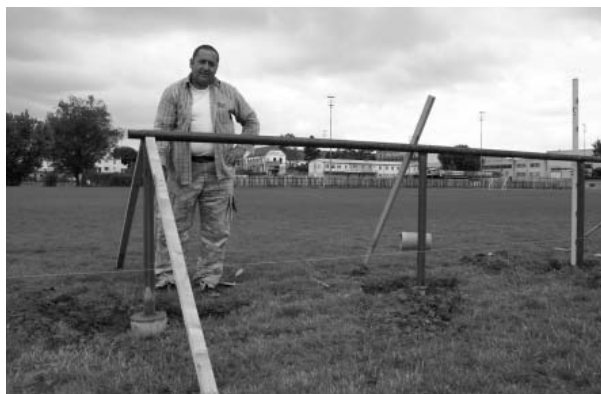
Usazování nového zábradlí kolem fotbalového hřiště.
