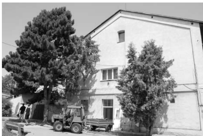
Bytový dům na ul. Tovární po opravě přímo volal, nyní jsou vodovody i odpady v pořádku.
