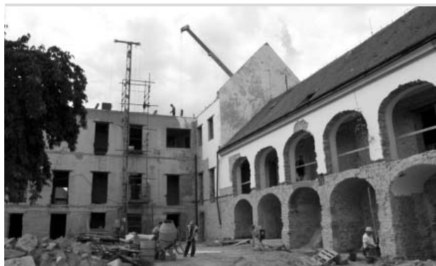
Dvůr zámečku s ozdobnými arkádami, toho času bez střechy i krovů.
