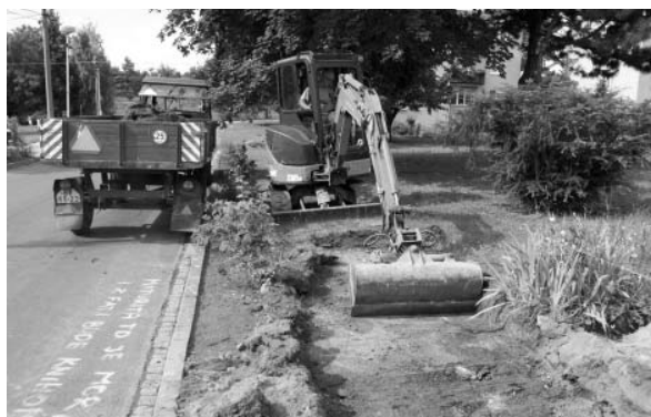
Pod lžící bagru vzniká místo určené pro nový chodník – ul. Herbenova.
