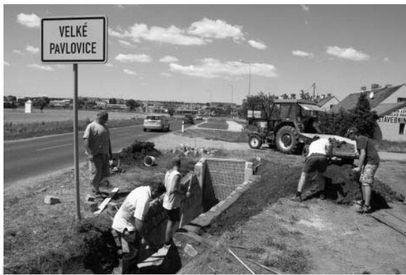
Stavební úpravy záchytného odvodňovacího žlabu na konci ulice Hodonínská.
