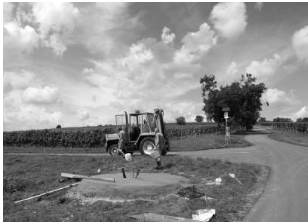
Na křižovatce pod rozhlednou Slunečná vzniká nové příjemné posezení...
