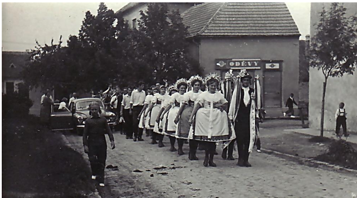
Pohled od kostela na ulici Bezručovu
