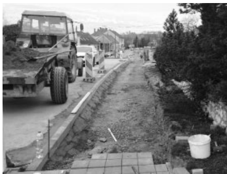
Oprava chodníku na ulici Starohorská – směr Zelnice.
