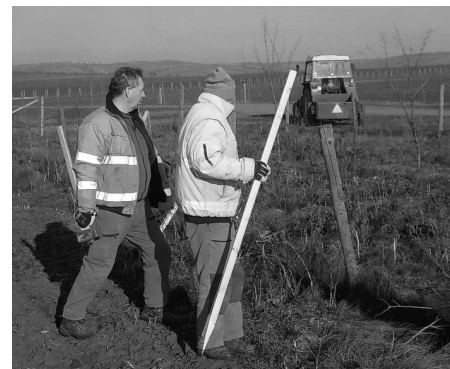
Oprava oplocení z lesnického pletiva, které zde bylo nainstalováno z důvodu ochrany nově vysazené zeleně.
