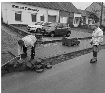
Pracovníci služeb města se pustili do opravy chodníku na ulici Starohorská.
