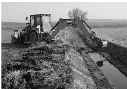
Těžká technika firmy BLARA, s.r.o. čistí zanesený žlab od čističky odpadních vod.
