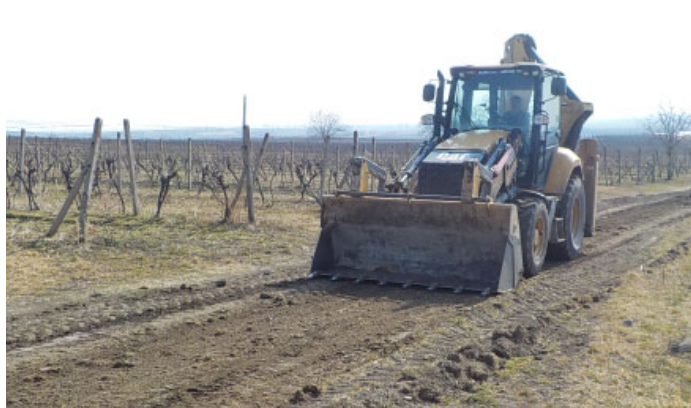
OPRAVA POLNÍ CESTY VE VINIČNÍ TRATI NAD ZAHRADY pracovníky služeb města
